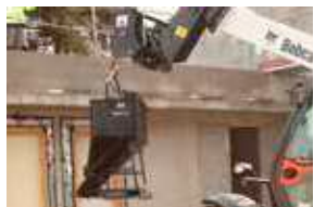
Бункер для бетона P. 201
